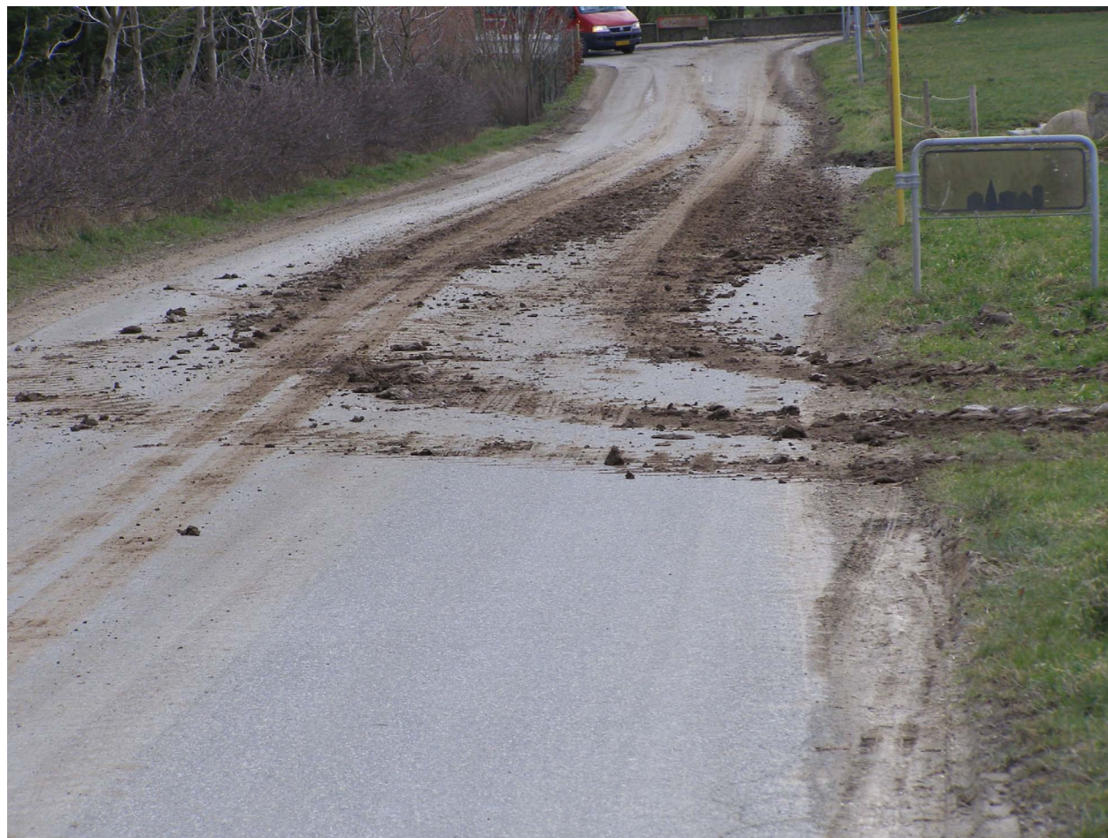
Forurening af vej er vanskeligt at undgå, men der skal senest ryddes op ved arbejdstids ophør. Foto: Jens J. Høy, AgroTech.
